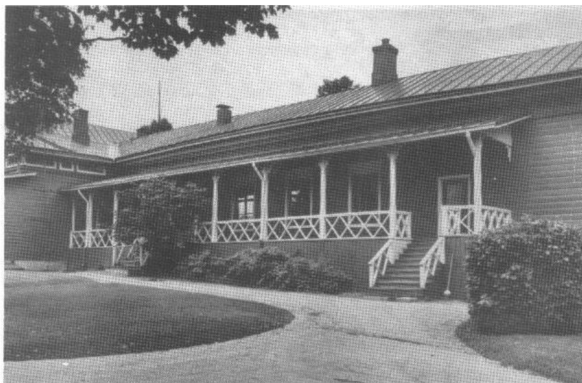
Kauppalan virastotalo pihan puolelta.
