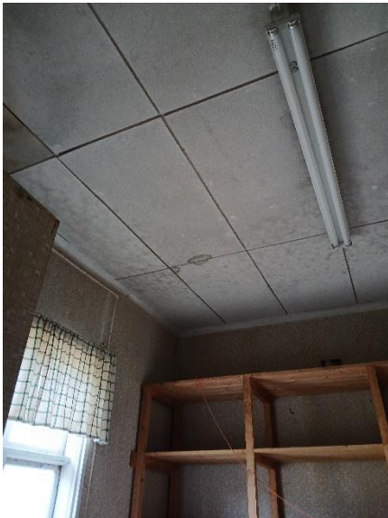
Kuva 44 Pinoissa pintamikrobia myös tiloissa, joissa ei kattovuotoa sisätilaan saakka
