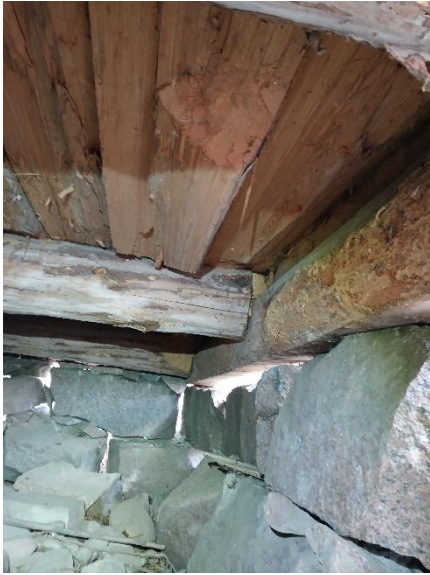
Kuva 7 Alapohjan kantavien palkkien tuenta kehäpalkin päältä.
