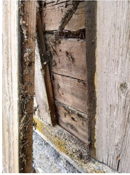
Kuva 30 Hirsiseinässä ei vaurioita idän puolella rakenneavauksessa
