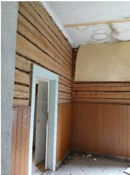
Kuva 31 Hirsirungon pinnoissa ei vaurioita sisäpuolelta tarkasteltaessa
