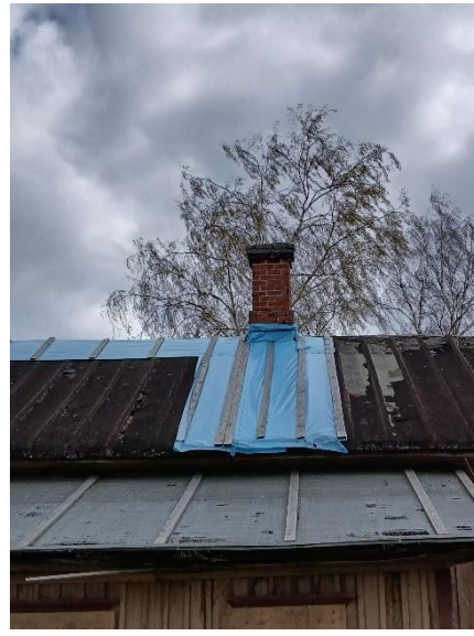
Kuva 47 Hätäkorjausta- katteessa vaurioita myös korjauksen vierellä
