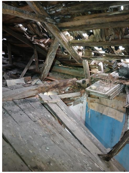
Kuva 39 Välipohja ullakkoportailta katsoen
