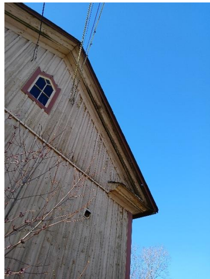
Kuva 53 Räystäslaudoitusta.
