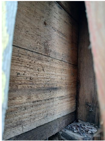
Kuva 28 Kuistin osalla ulkoseinä runko + laudoitus.
