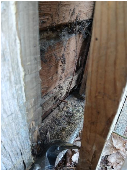
Kuva 27 Hirsiseinäessä ei havaittu vaurioita länsiseinällä kuistin vasemmalla puolella
