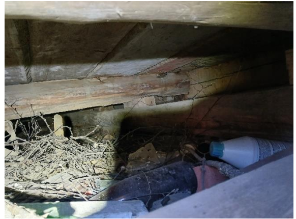
Kuva 12 Kuistin alapohja tarkastusluukusta kuvattuna
