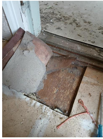
Kuva 43 Lattian pinnassa useampi kerros
