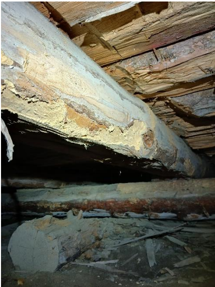
Kuva 13 Hyönteisten aiheuttamia tuhoja kantavissa alapohjapalkeissa
