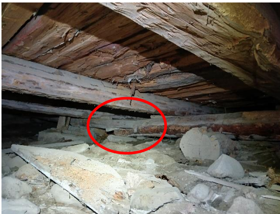
Kuva 7 Alapohjan kantavien palkkien tuenta kehäpalkin päältä.
