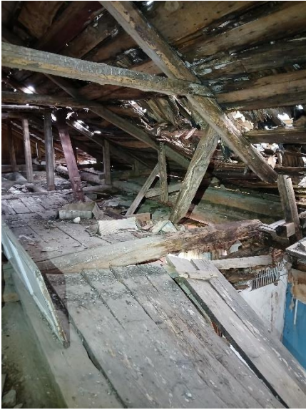
Kuva 54 Ullakko- kattorakenne ja sen tukeutuminen.
