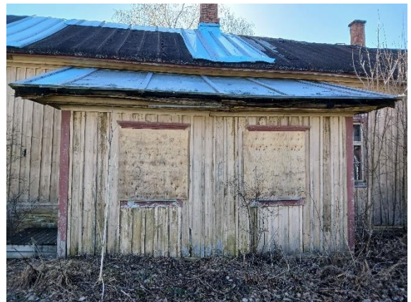
Kuva 47 Hätäkorjausta- katteessa vaurioita myös korjauksen vierellä
