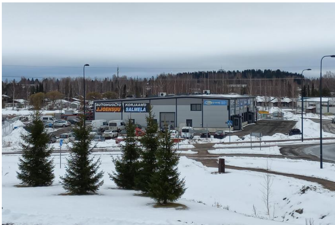
Kuva 2. Suunnittelualue eteläpuolelta kuvattuna.
