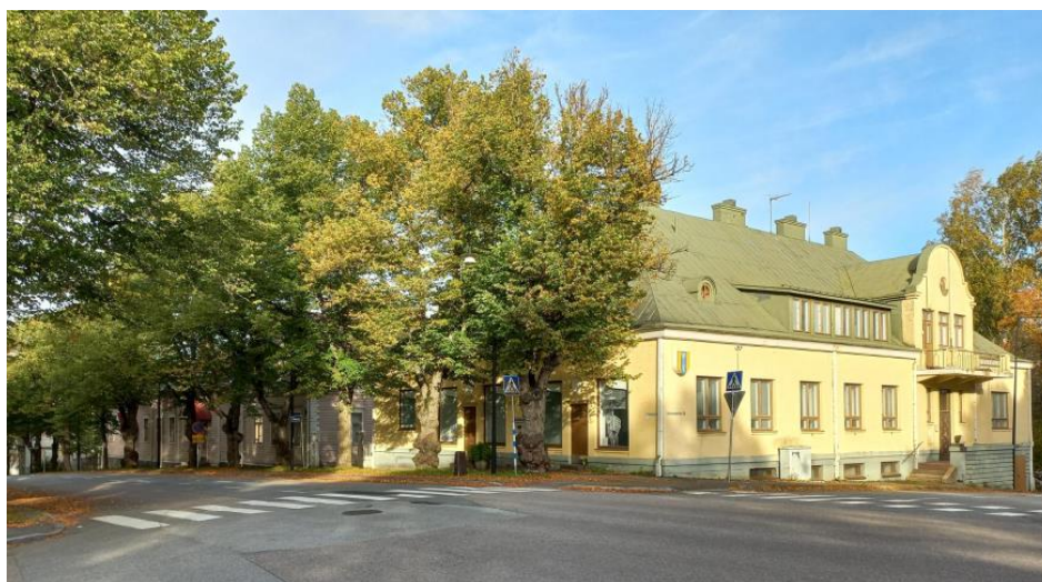
Kuva 4. Näkymä Valtakadun ja Kyrösselänkadun risteyksestä suunnittelualueelle. Etualalla keltainen varasto.
