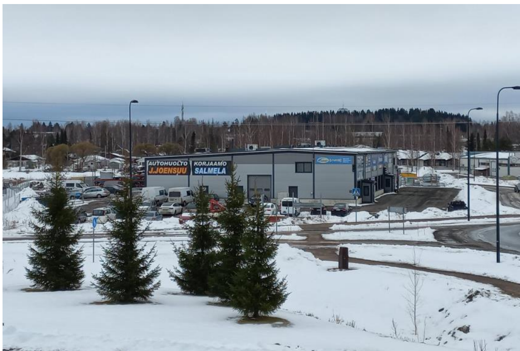
Kuva 2. Suunnittelualue eteläpuolelta kuvattuna.
