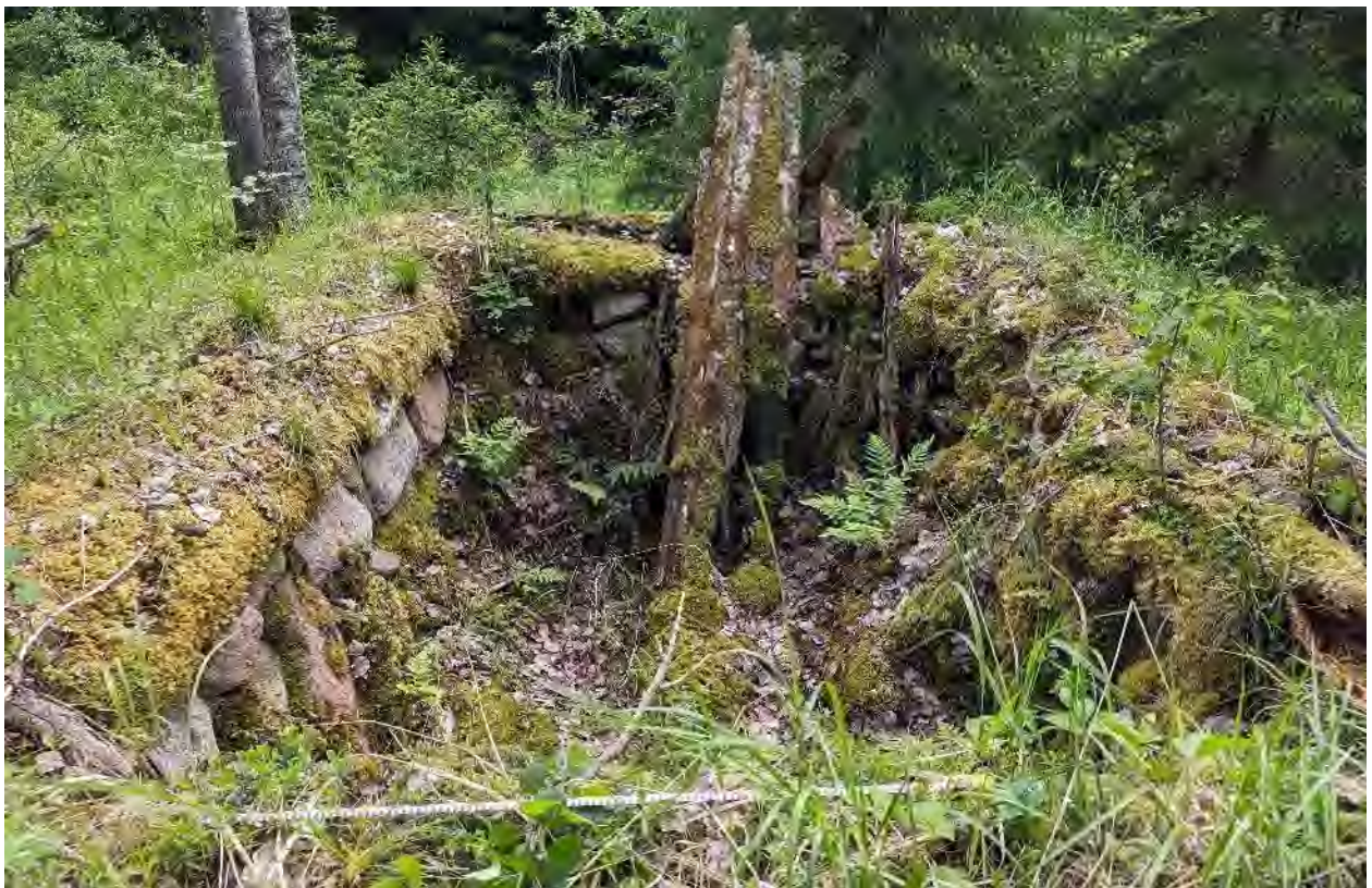
Kuva 7. Kellarikuopan reunalla on jäänteitä lahonneista kattorakenteista. Kuvattu itään.
