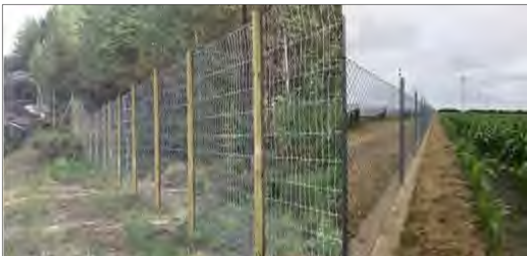
Kuva 2. Esimerkki riista-aidasta puutopilla (kuva vasemmalla) ja teollisuusaidan toteutuksesta, jossa on sisäpuolinen ylityssuojaus sähkölangoin (kuva oikealla).
