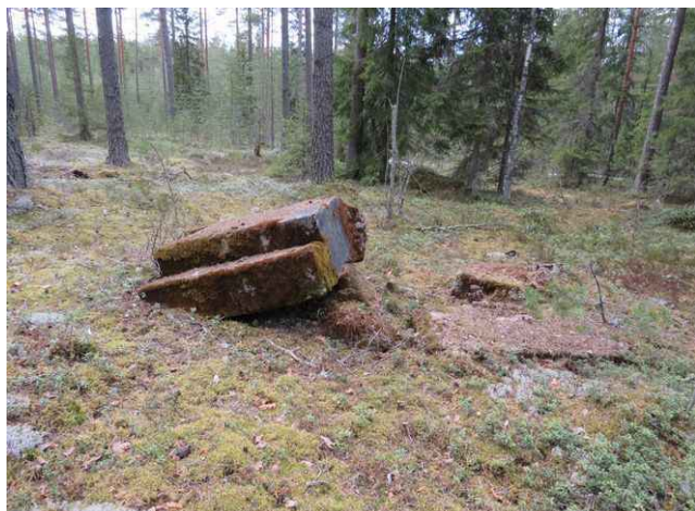
8. Betoniportaat metsässä, Kuoppainmäki.
