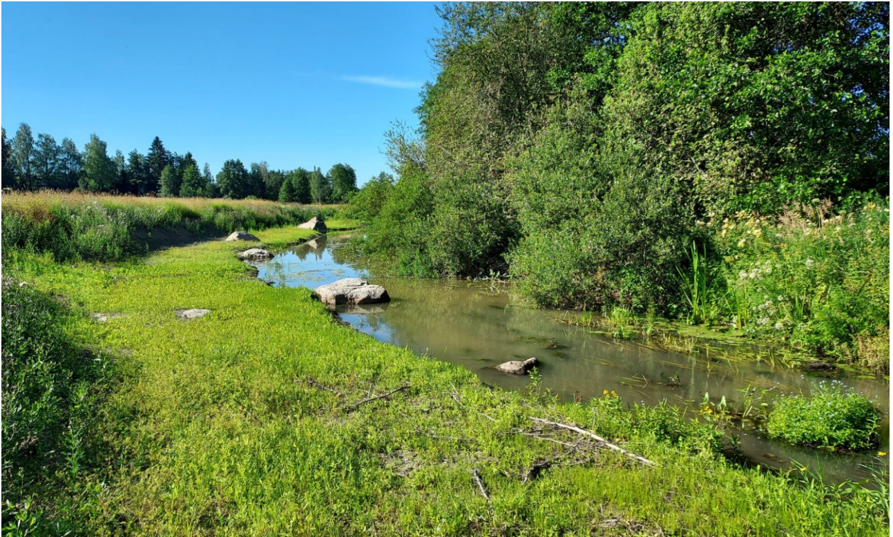
Kuva 9. Kaksitasouoma ja toisen puoleinen tulvatasanne. Kuva Mikko Ortamala, KVVY Tutkimus Oy.
