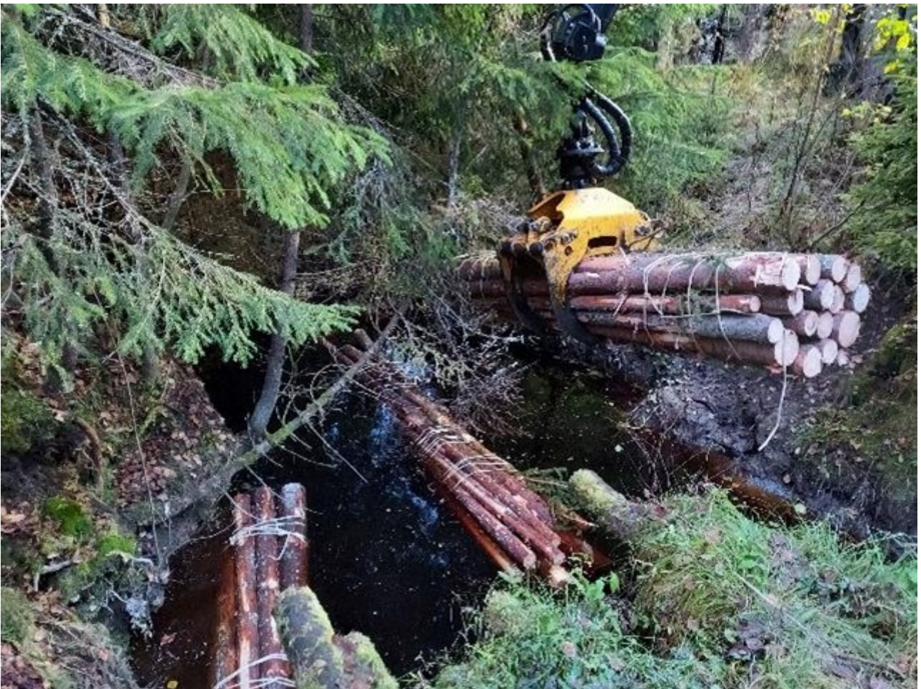
Kuva 7. Sidottuja rankanippuja poikittain uomassa. Yksittäisten nippujen rakentaminen ja asentaminen voi onnistua tarvittaessa myös käsityökaluin. Kuva Elina Nystedt, KVVY Yhdistys.
