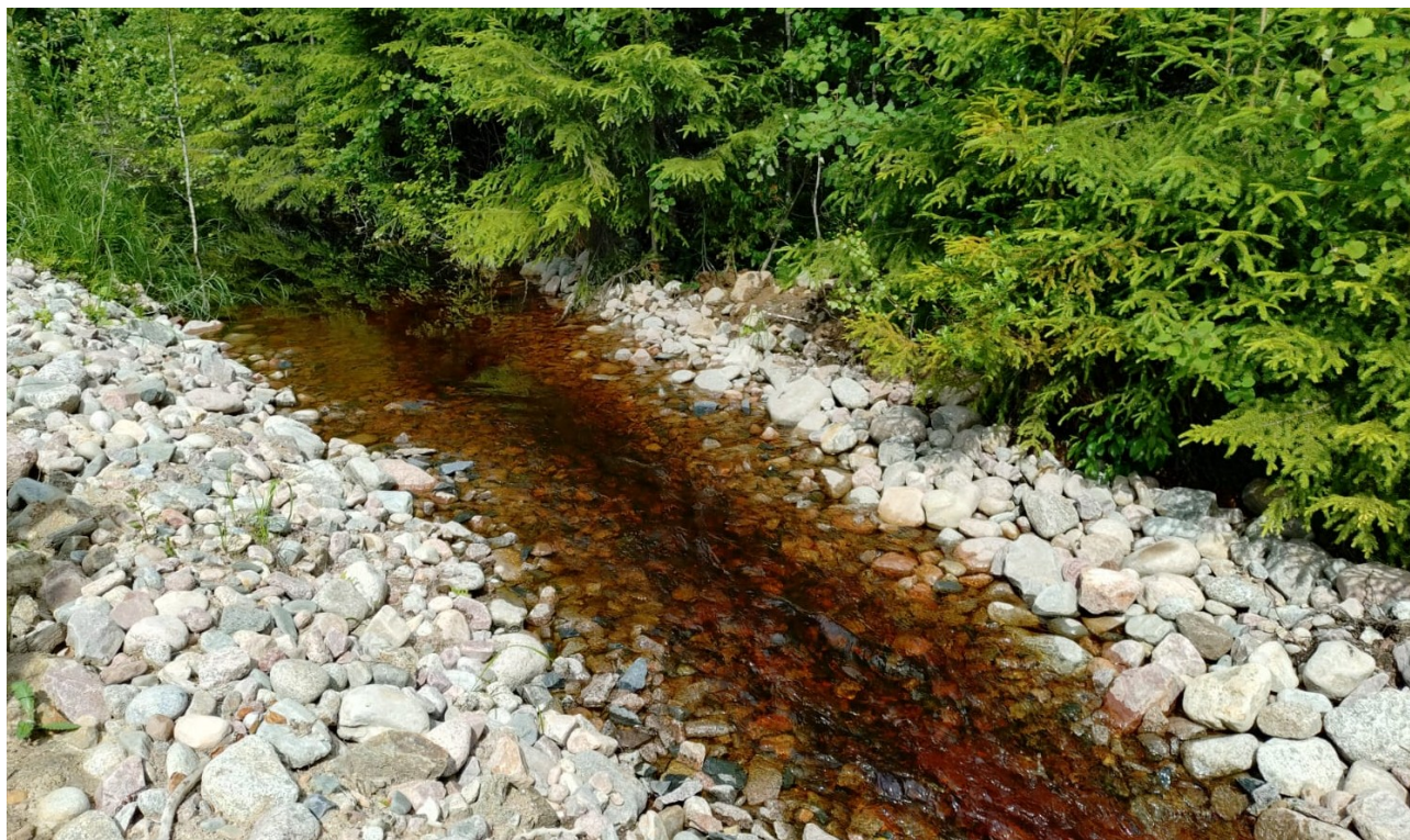
Kuva 6. Pohjakynnyksen virtausramppi verhoillaan kiviaineksella. Kuva Kaisa Kätikävaara, KVVY.
