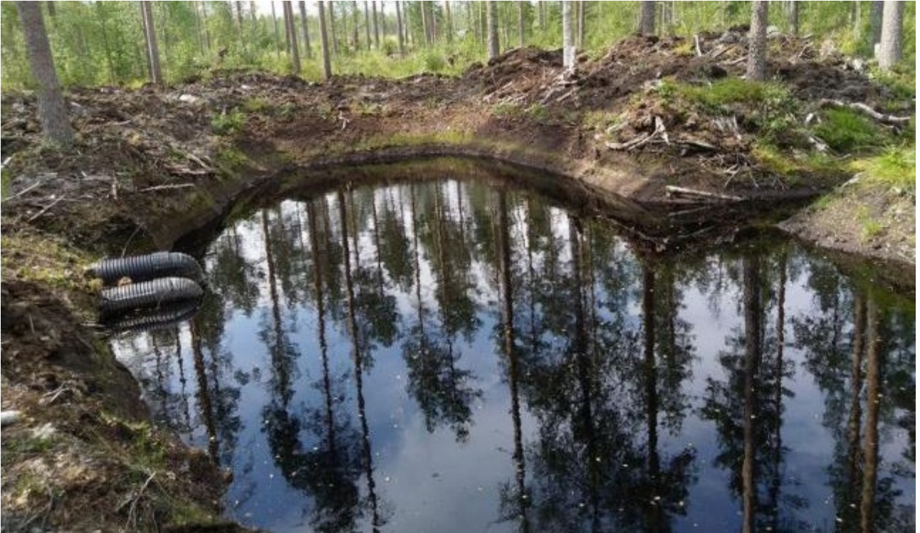
Kuva 4. Laskeutusallas, josta vedet on ohjattu eteenpäin putkipatorakenteen kautta. Kuva Elina Nystedt, KVVY Yhdistys.
