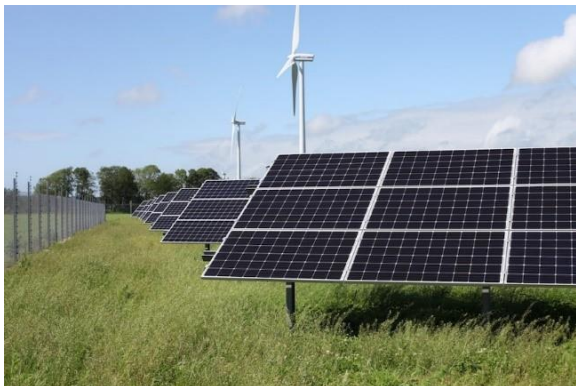
Kuva 3. Esimerkki piikennopaneeleista alumiinikehyksellä maatelinerakenteessa (vasemmalla). Kuvassa näkyy Varberg Energin Solsidan-puisto Tvååkerissa. Esimerkki aurinkopaneeleista yksiakselisilla seurantalaitteilla (oikealla).
