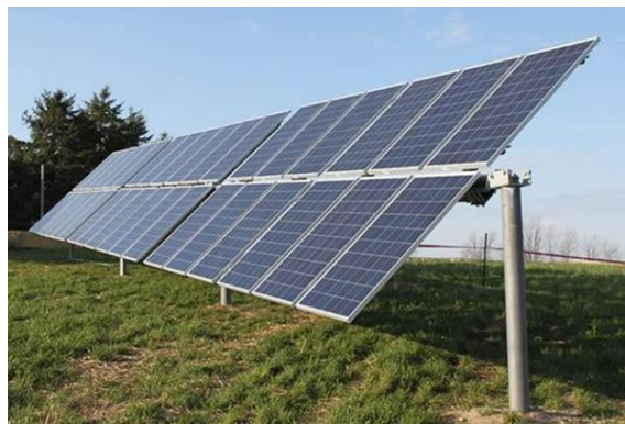
Kuva 3. Esimerkki piikennopaneeleista alumiinikehyksellä maatelinerakenteessa (vasemmalla). Kuvassa näkyy Varberg Energin Solsidan-puisto Tvååkerissa. Esimerkki aurinkopaneeleista yksiakselisilla seurantalaitteilla (oikealla).
