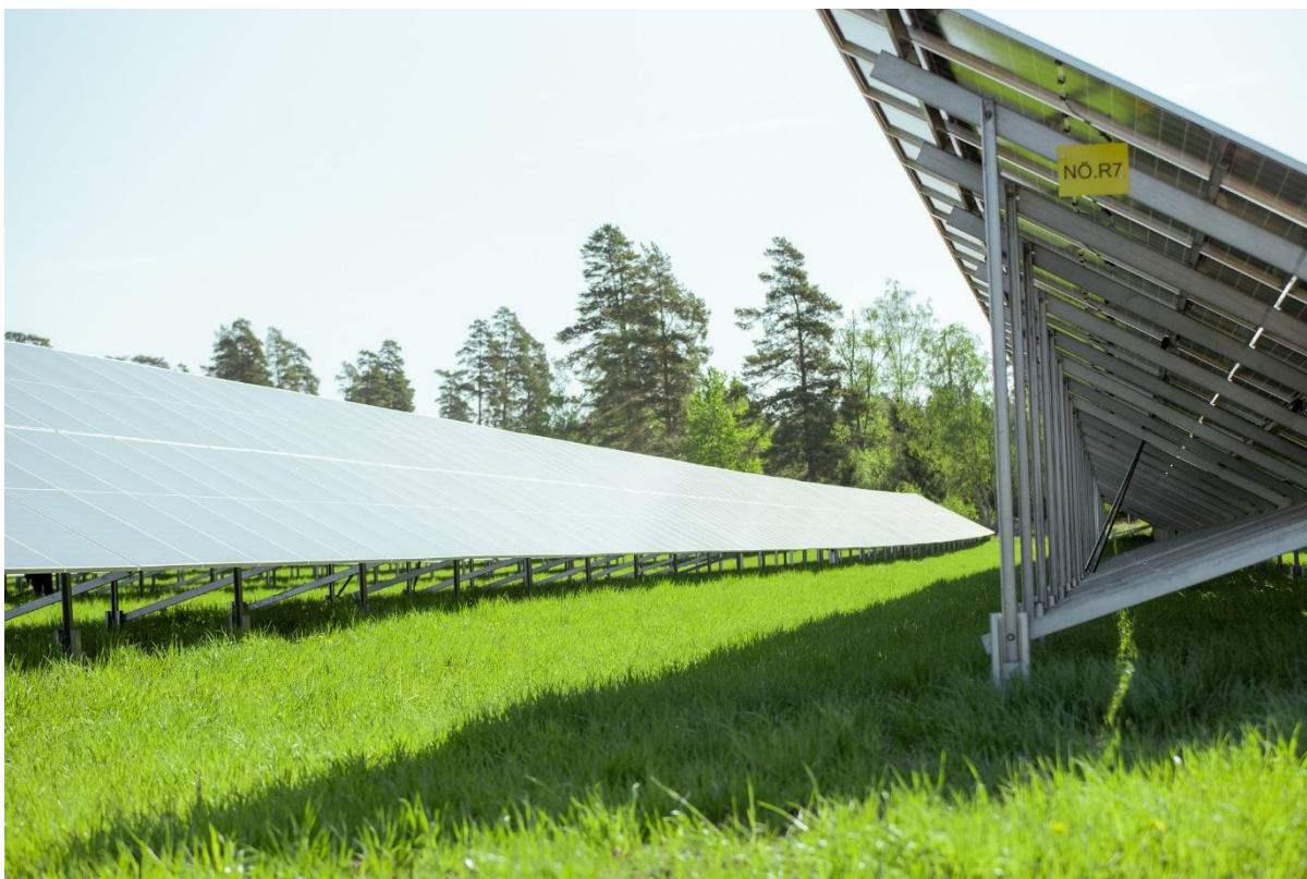
Kuva 4. Aurinkopaneelit asennetaan pitkiin riveihin, joiden välinen etäisyys on noin 5–6 metriä, ja ruoho sekä muut kasvit voivat kasvaa paneelien alla. Maa-alueita ei siis päällystetä, mikä mahdollistaa huleveden imeytymisen maaperään.
