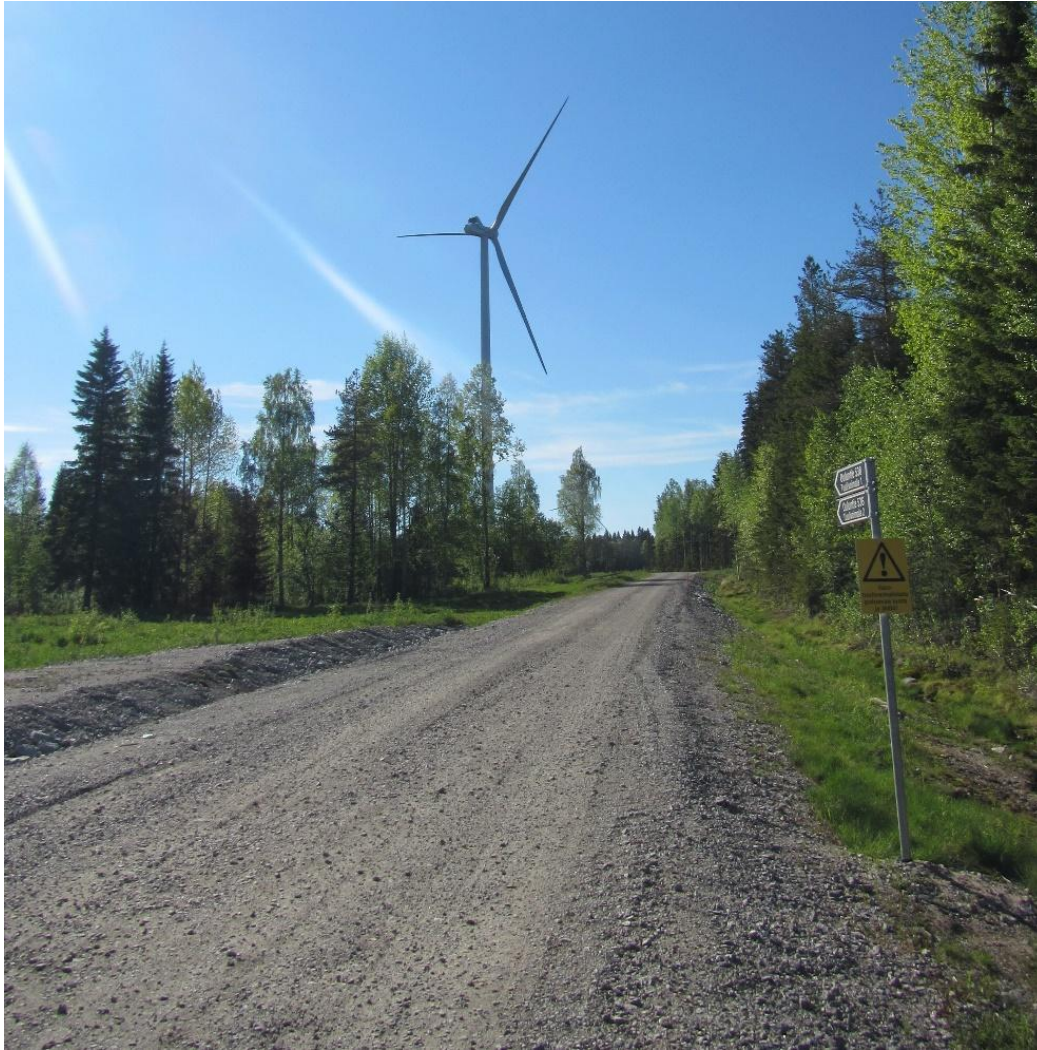
Kuva 5-3. Esimerkki tuulivoimapuiston rakennus- ja huoltotiestä. © AFRY Finland Oy.
